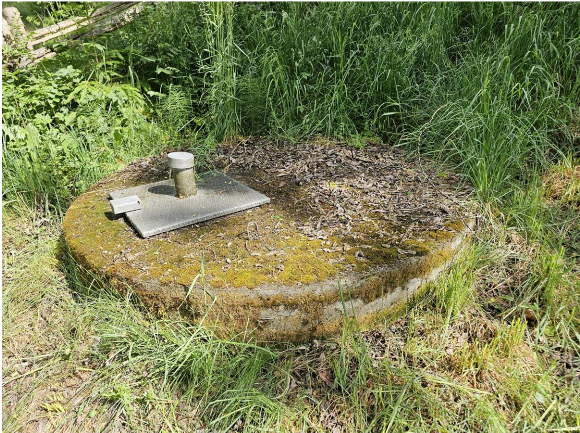
Abb. 3k: Zmöllach 12A – Ältere Betonquellfassung mit Metallabdeckung und Lüftungsrohr, stark bemooste Oberfläche deutet auf langen Betrieb hin. Feldaufnahme 31. Mai 2026.
